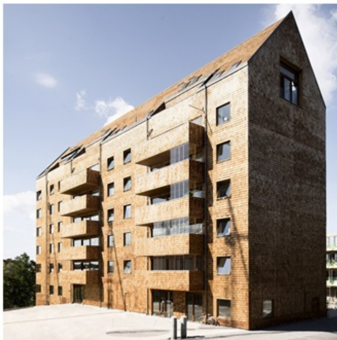
Рис. 2 - Восьмиэтажный дом высотой 26 м в Стокгольме.
