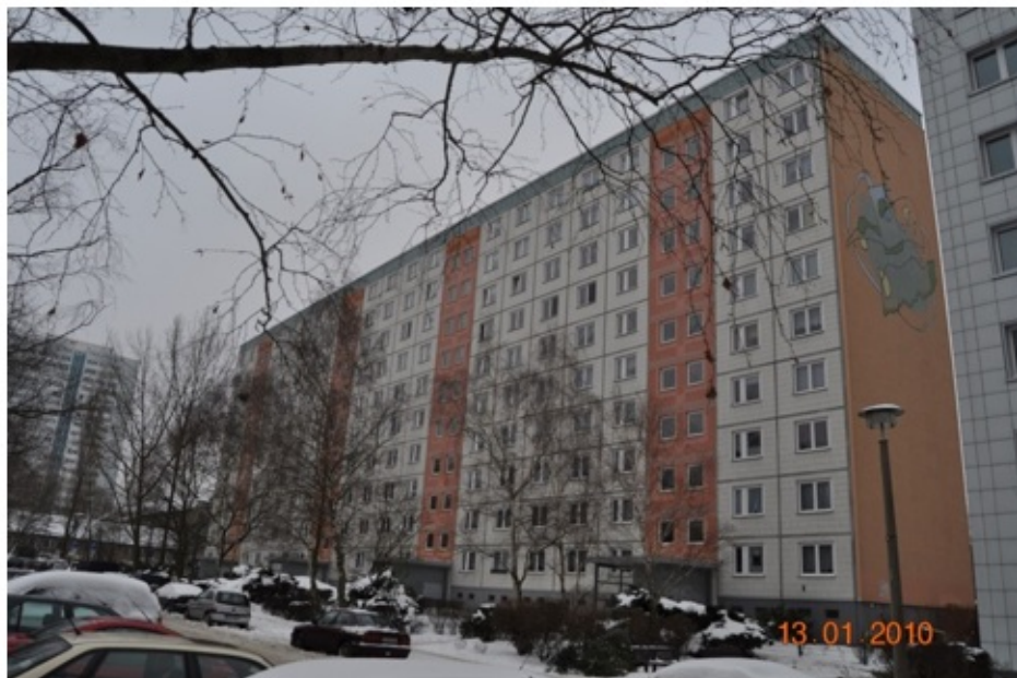
Рис.6- Германия. Вид панельных зданий после реновации фасада по технологии ППШ.
