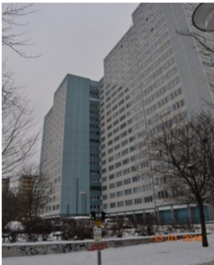
Рис.5- Германия. Вид панельных зданий после реновации фасада по технологии ППШ.
