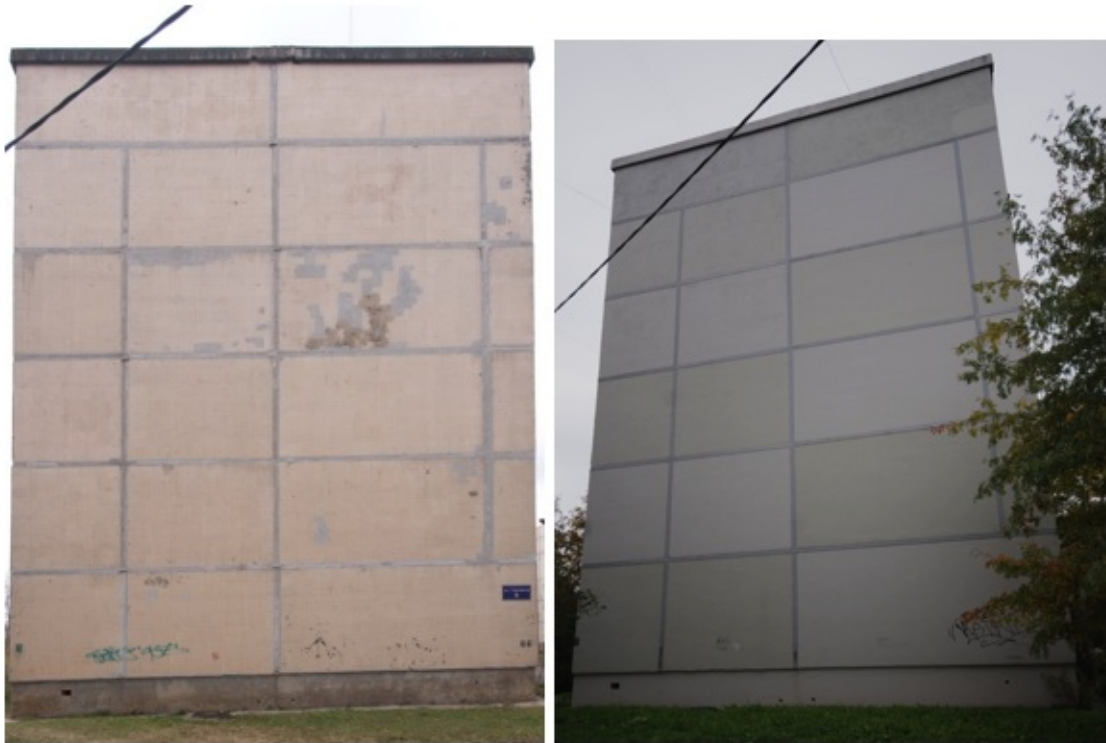
Рис. 4 — Ленинградская область, г. Пикалёво. Вид фасада до ремонта по технологии ППШ и четыре года спустя.
